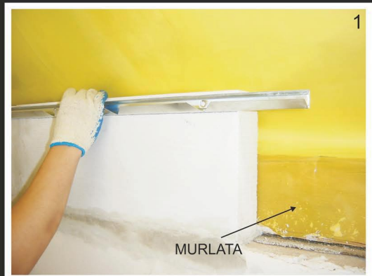
1. На штыри быстрого монтажа крепим горизонтально профиль-V
