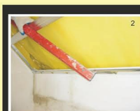
2. От профиля-V намечаем наклон. Первый CD 60 максимально 600 мм от профиля-V
