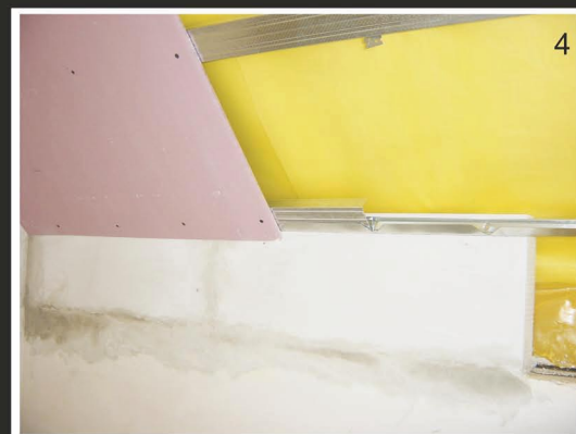
4. Лист прикручиваем сначала к CD 60 а в конце к профилю-V
