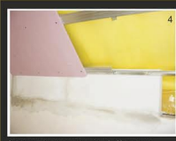
4. Лист прикручиваем сначала к CD 60 а в конце к профилю-V
