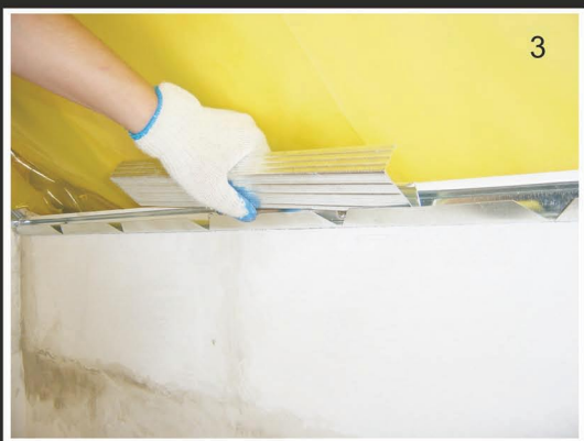
3. агнутый CD 60 вводим в место стыка листов или используем как удлинитель профиля-V.
