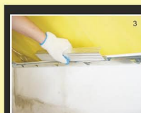
3. Загнутый CD 60 вводим в место стыка листов или используем как удлинитель профиля-V
