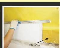
1. На штыри быстрого монтажа крепим горизонтально профиль-V
