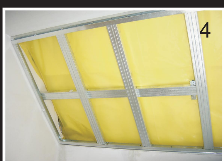
4. W PRZYPADKU ROZSTAWU UD 30 POWYŻEJ 600MM STOSUJEMY ŁACZNIKI KRZYŻOWE I PODWIESZAMY POPRZECZNIE PROFIL CD 60 NA WIESZAKACH
