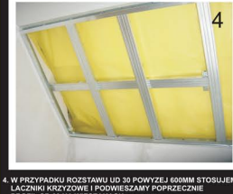
4. W PRZYPADKU ROZSTAWU UD 30 POWYŻEJ 600MM STOSUJEMY ŁACZNIKI KRZYŻOWE I PODWIESZAMY POPRZECZNIE PROFIL CD 60 NA WIESZAKACH
