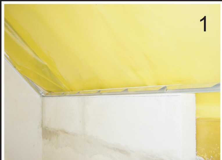
1. DO KOLANKOWEJ MONTUJEMY W POZIOMIE ODWRÓCONY PROFIL-V NA KOŁKI SZYBKIEGO MONTAŻU.
