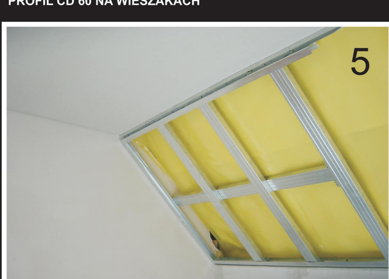
5. TAK PRZYGOTOWANY RUSZT ZAMYKAMY PLYTA GK
