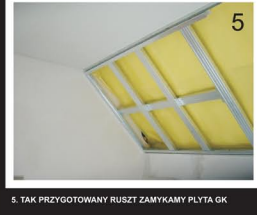
5. TAK PRZYGOTOWANY RUSZT ZAMYKAMY PLYTA GK
