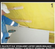
1. DLA PŁYT G-K STOSUJEMY LISTWY UMOŻLIWIAJĄCE ZAMOCOWANIE PROFILU - V DO PŁYT. STOSUJĄC PŁYTY G-W PROFIL - V MONTUJEMY BEZPOŚREDNIO DO PŁYTY.
