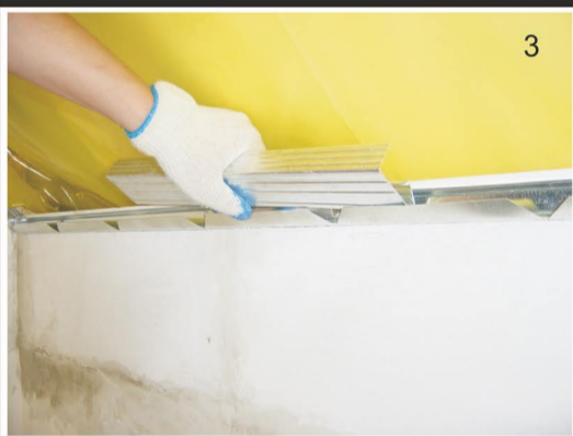
3. ZAGIĘTY CD 60 WKLIKUJEMY EWENTUALNIE W MIEJSCE ŁĄCZENIA PŁYT LUB STOSUJEMY JAKO ŁĄCZNIK WZDŁUŻNY PROFILU-V
