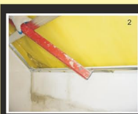
2. Z PROFILU-V WYTYCZAMY SKOS. PIERWSZY CD 60 MAX 400MM OD PROFILU-V
