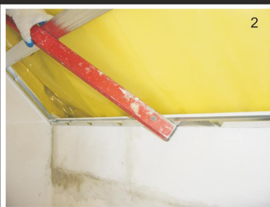
2. Z PROFILU-V WYTYCZAMY SKOS. PIERWSZY CD 60 MAX 400MM OD PROFILU-V
