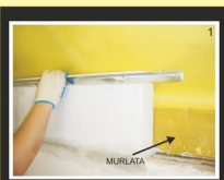
1. NA KOLKI SZYBKIEGO MONTAŻU MONTUJEMY W POZIOMIE PROFIL-V
