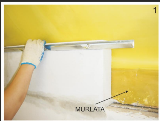
1. NA KOLKI SZYBKIEGO MONTAŻU MONTUJEMY W POZIOMIE PROFIL-V
