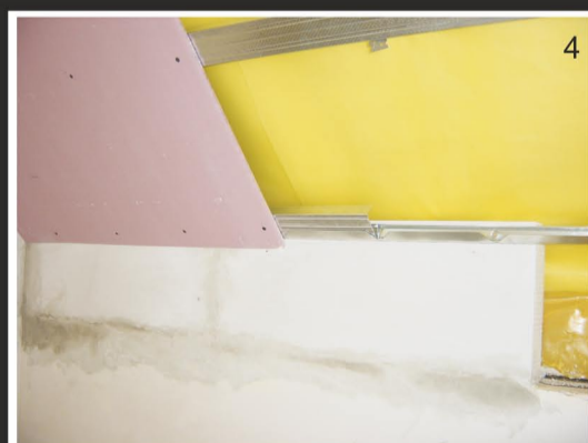
4. PŁYTE PRZYKRECAMY NAJPIERW DO CD 60 A NA KONCU DO PROFILU-V
