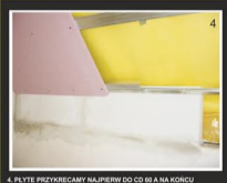
4. PŁYTE PRZYKRECAMY NAJPIERW DO CD 60 A NA KONCU DO PROFILU-V
