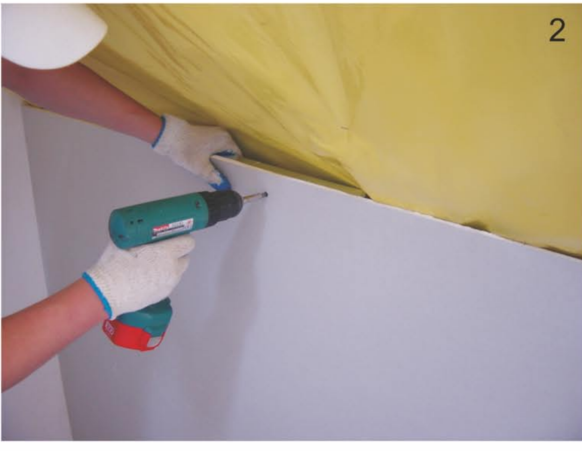
2. ODCINKI CD 60 PRZYKRECAMY WKRETAMI FS PRZEZ PŁYTĘ PROFIL CD 60 POSŁUZY NAM DO MONTAŻU PROFILI-V
