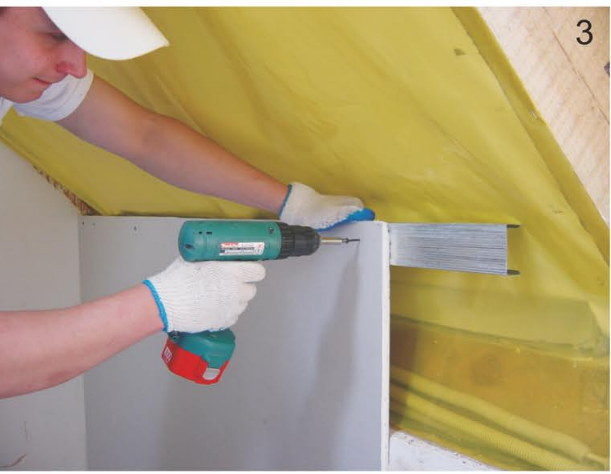
3. W MIEJSCACH ŁĄCZENIA PŁYTY ZASTOSOWAC CD 60
