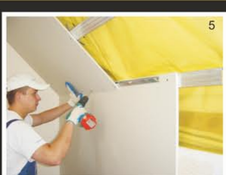
5. PRZYKRECAMY PŁYTĘ DO RUSZTU SKOSU. PRZYKRECANIE PŁYT ROZPOCZYAMY OD PROFILI CD 60 I KOŃCZYMY PRZYKRECAJĄC DO PROFILU -V
