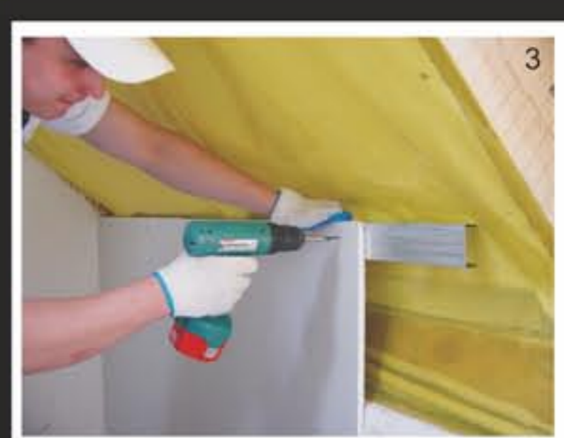
3. W MIEJSCACH ŁĄCZENIA PŁYTY ZASTOSOWAC CD 60
