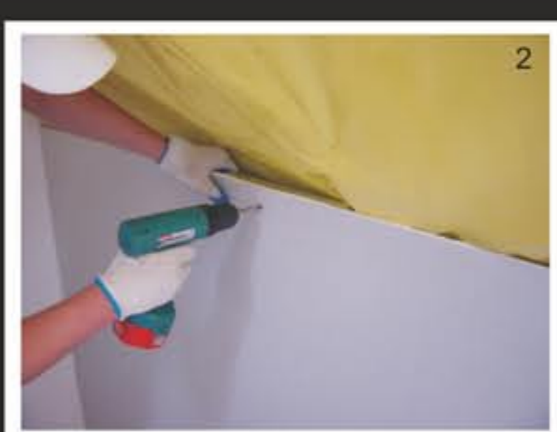
2. ODCINKI CD 60 PRZYKRECAMY WKRETAMI FS PRZEZ PŁYTĘ PROFIL CD 60 POSŁUZY NAM DO MONTAŻU PROFILI-V
